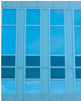
Fassadendetail, Bauteil B
