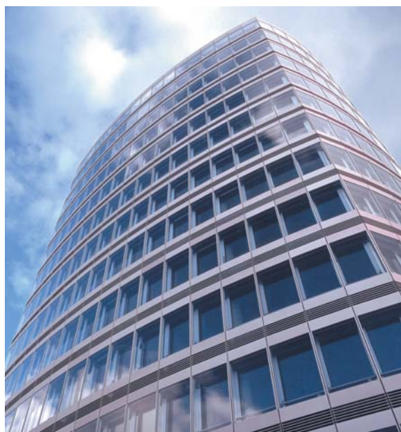
Vierseitig polygonal ausgebildete Fassade
