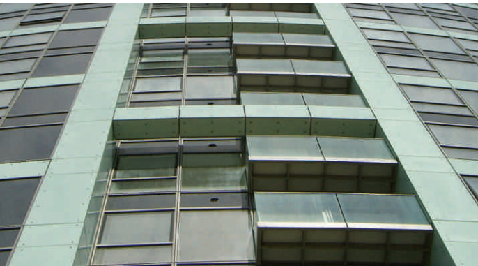
Elementfassade mit Balkonen
