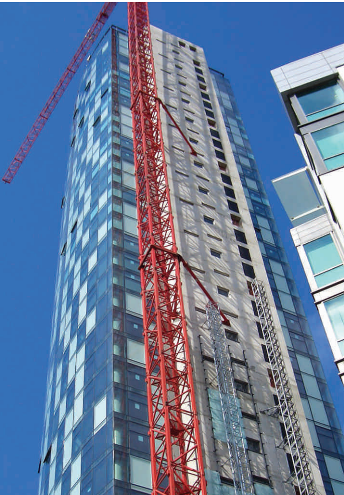
Turm in Bauphase
