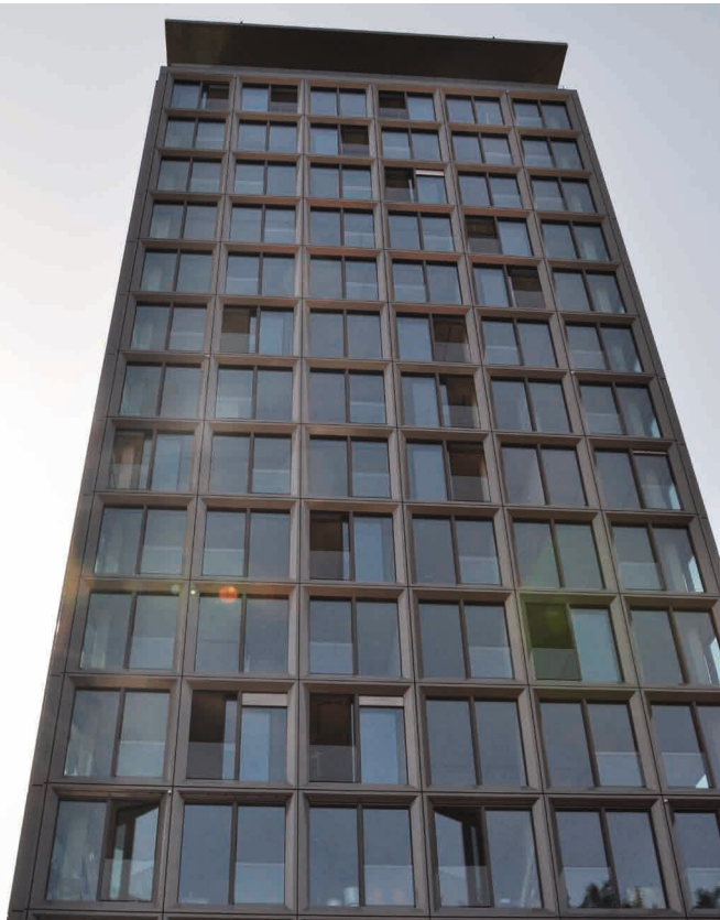
Hochhausfassade mit tw. geöffneten Horizontalschiebeflügel (HSF)
