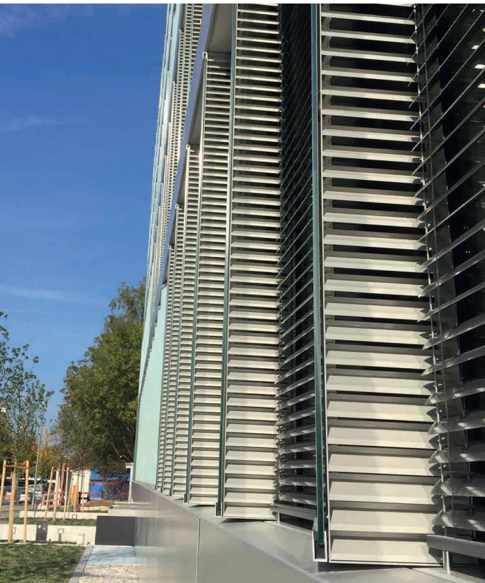
Ansicht der Lüftungslamellen
